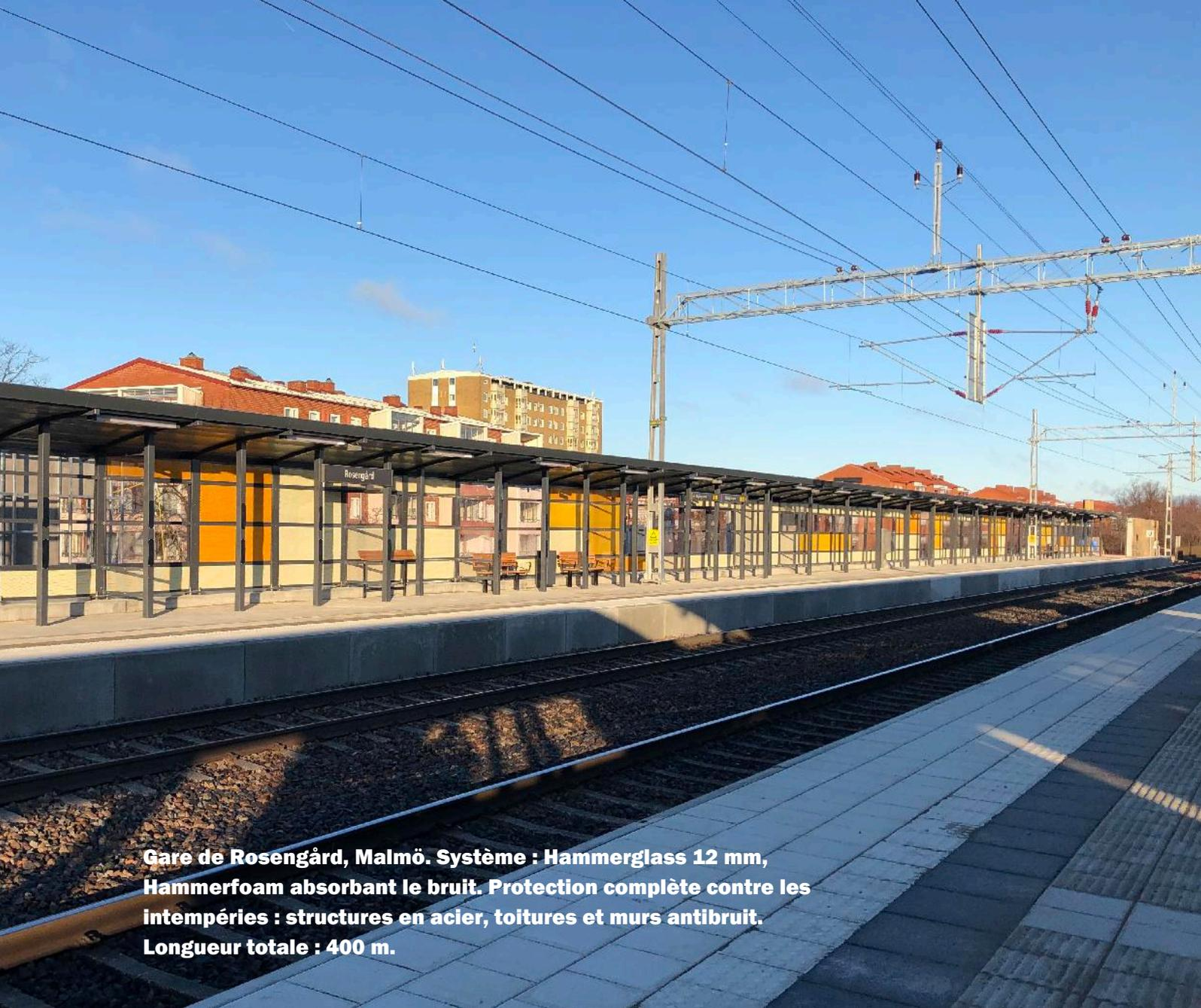
**Gare de Rosengård, Malmö. Système : Hammerglass 12 mm, Hammerfoam absorbant le bruit. Protection complète contre les intempéries : structures en acier, toitures et murs antibruit. Longueur totale : 400 m.**
