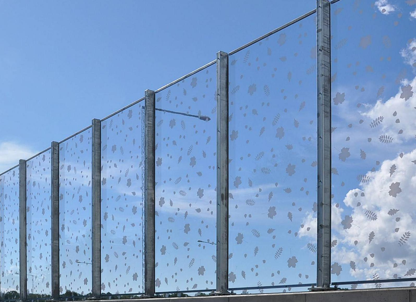
**Mur antibruit, Kalmar, Suède. Système : Ground-2 på mur, Hammerglass 12 mm. Le motif LAUB imprimé protège contre les collisions d'oiseaux. Hauteur : 2 - 5 m. Longueur : 750 m.**
