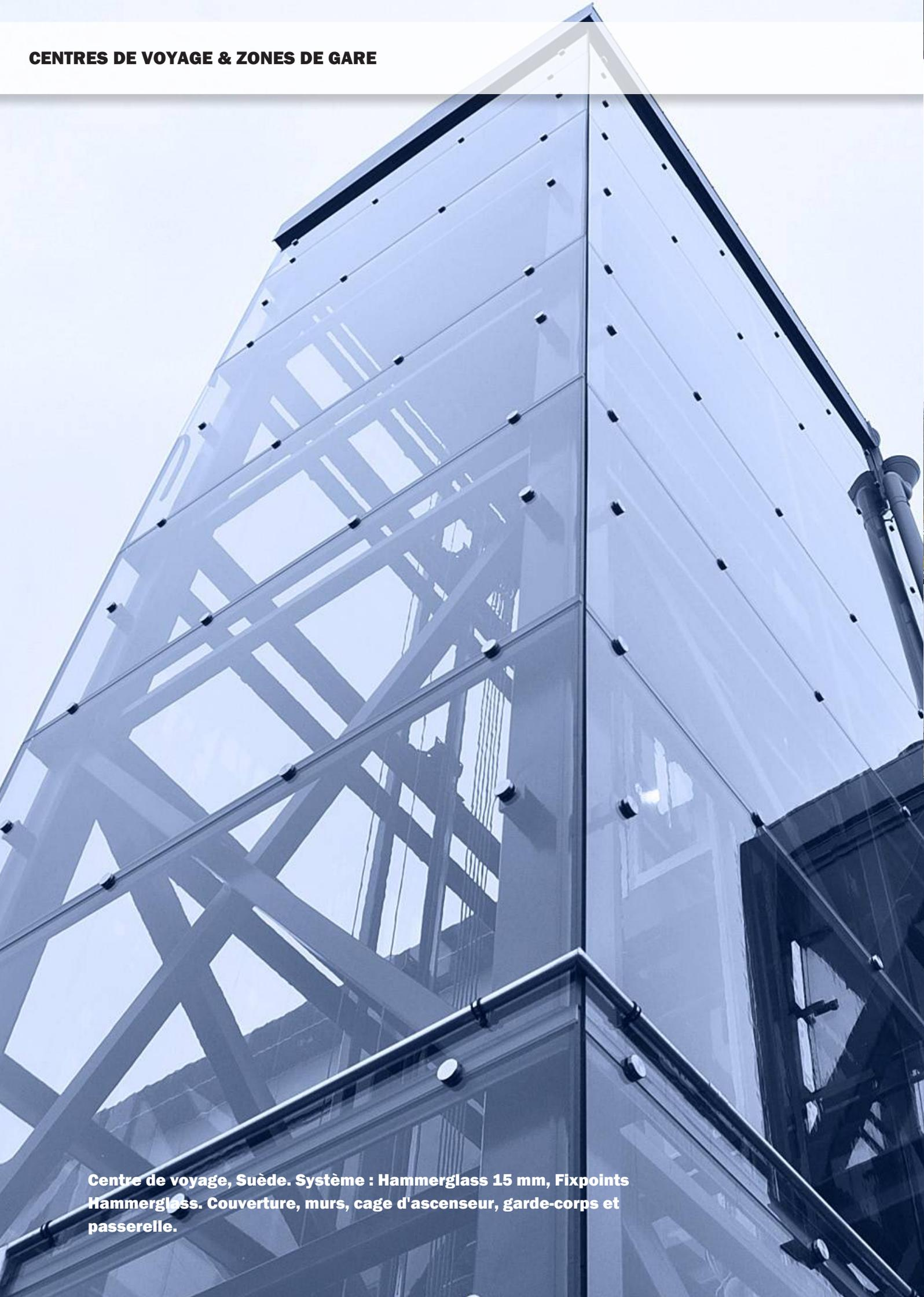
**Centre de voyage, Suède. Système : Hammergeass 15 mm, Fixpoints Hammergeass. Couverture, murs, cage d'ascenseur, garde-corps et passerelle.**
