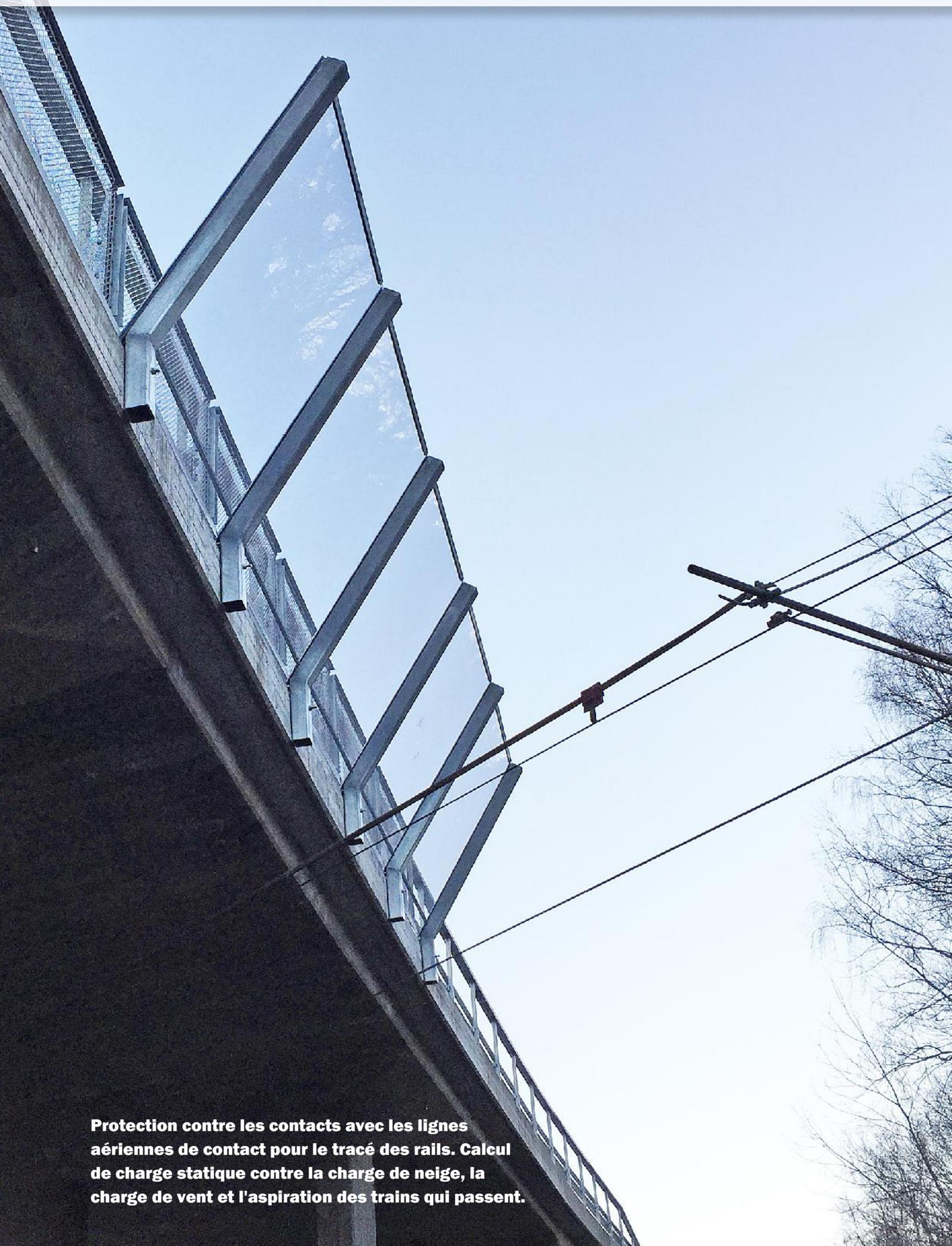
**Protection contre les contacts avec les lignes aériennes de contact pour le tracé des rails. Calcul de charge statique contre la charge de neige, la charge de vent et l'aspiration des trains qui passent.**
