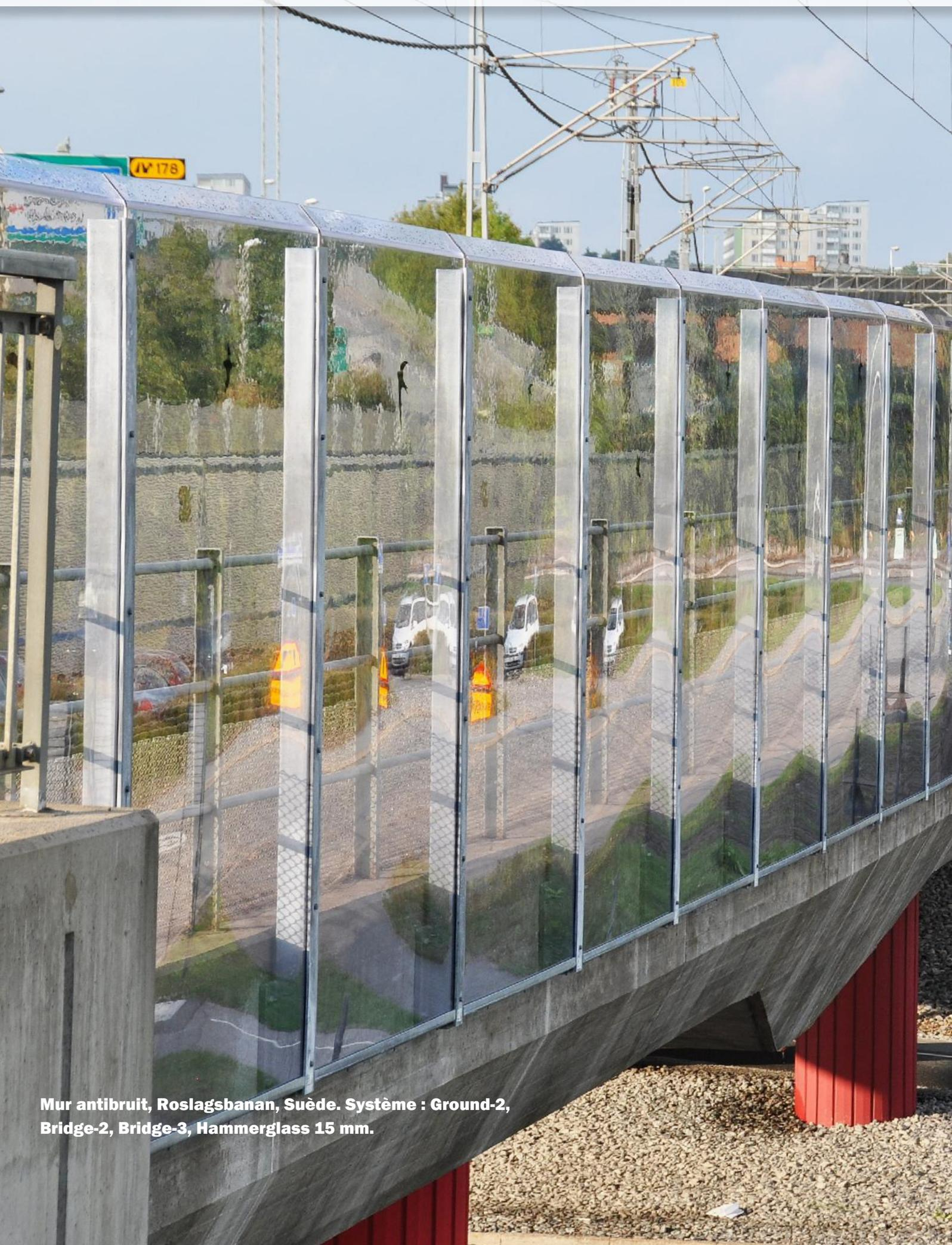
Mur antibruit, Roslagsbanan, Suède. Système : Ground-2, Bridge-2, Bridge-3, Hammerglass 15 mm.
