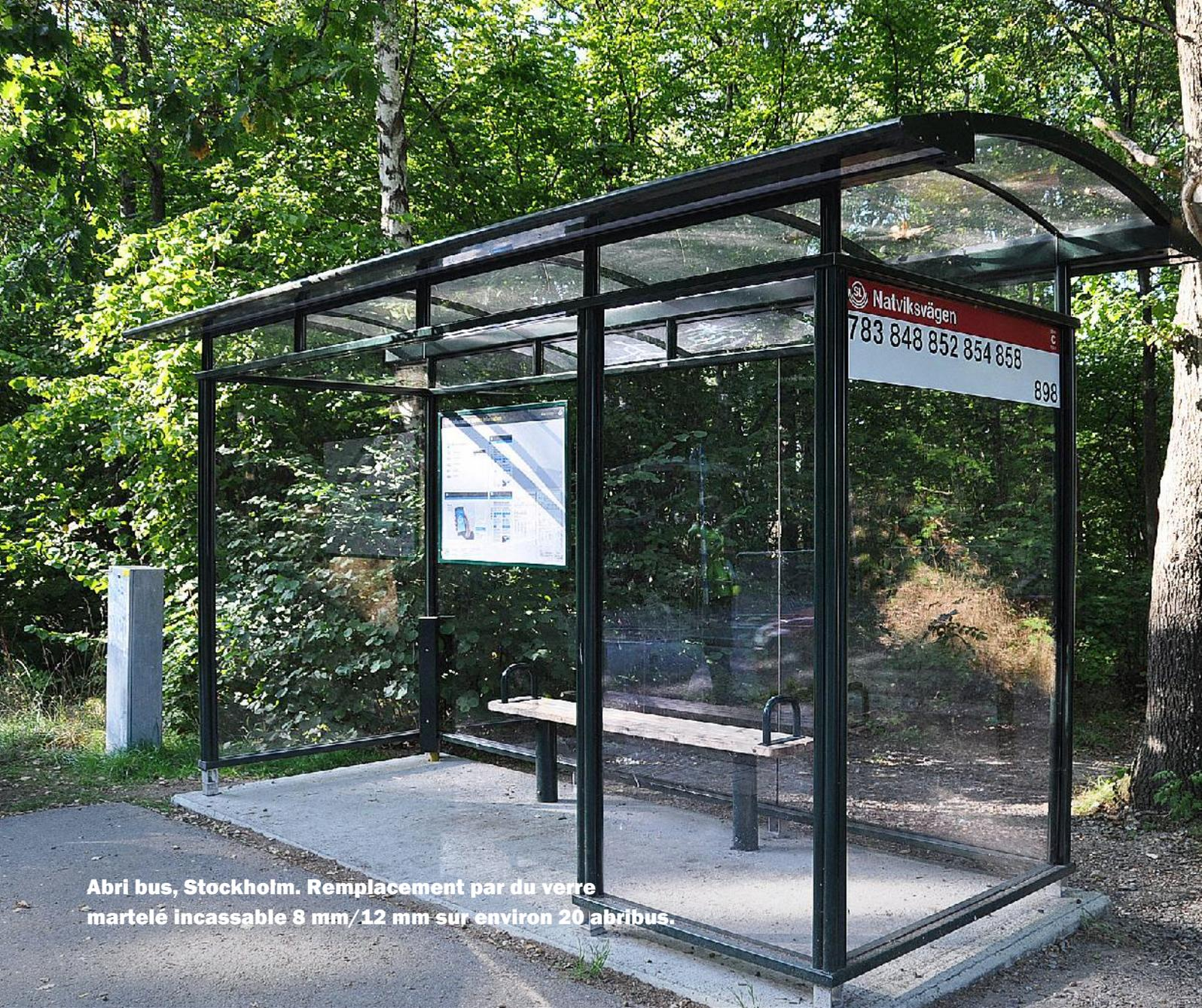
Abri bus, Stockholm. Remplacement par du verre martelé incassable 8 mm/12 mm sur environ 20 abribus.
