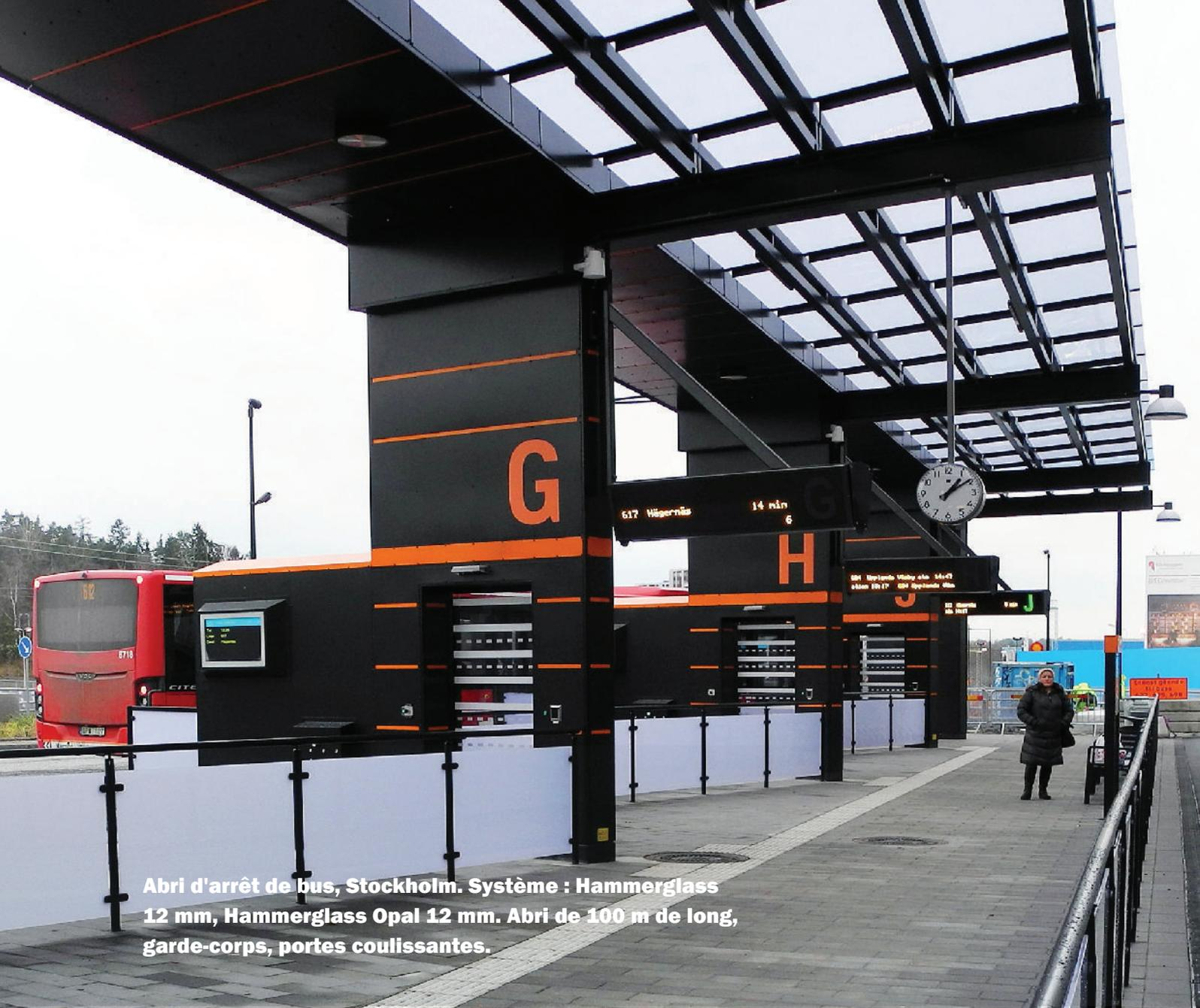
Abri d'arrêt de bus, Stockholm. Système : Hammerglass 12 mm, Hammerglass Opal 12 mm. Abri de 100 m de long, garde-corps, portes coulissantes.
